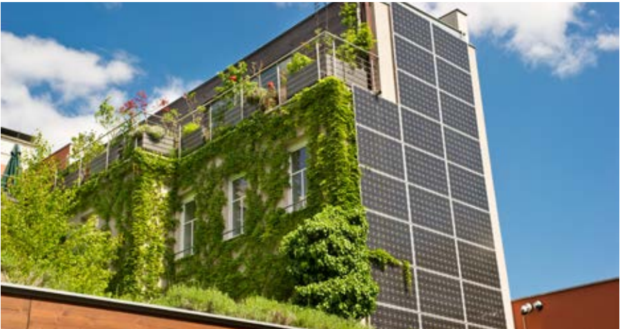
Begrünte Fassaden bzw. Dächer haben nachweislich einen positiven Einfluss auf das lokale Klima.
