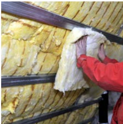
Mit einer thermischen Sanierung werden Heizkosten gespart und ein wichtiger Schritt in Richtung Anpassung an sommerliche Hitze getan.
