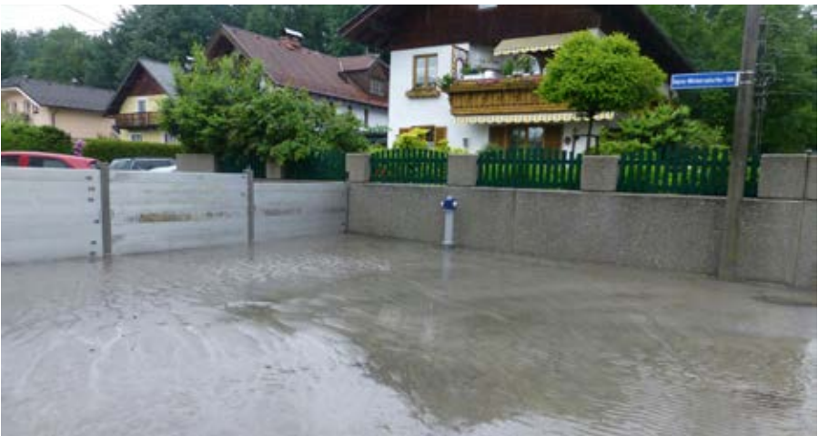
Auf das steigende lokale Hochwasserrisiko wird mit effektiven Schutzmaßnahmen reagiert.
