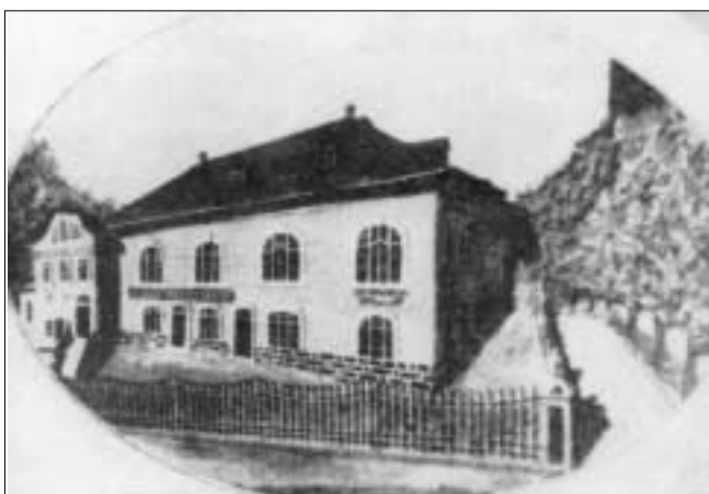
Das Gewerkschaftshaus in Bozen (aus ASGB, Das ASGB-Haus, Bozen 1998)
