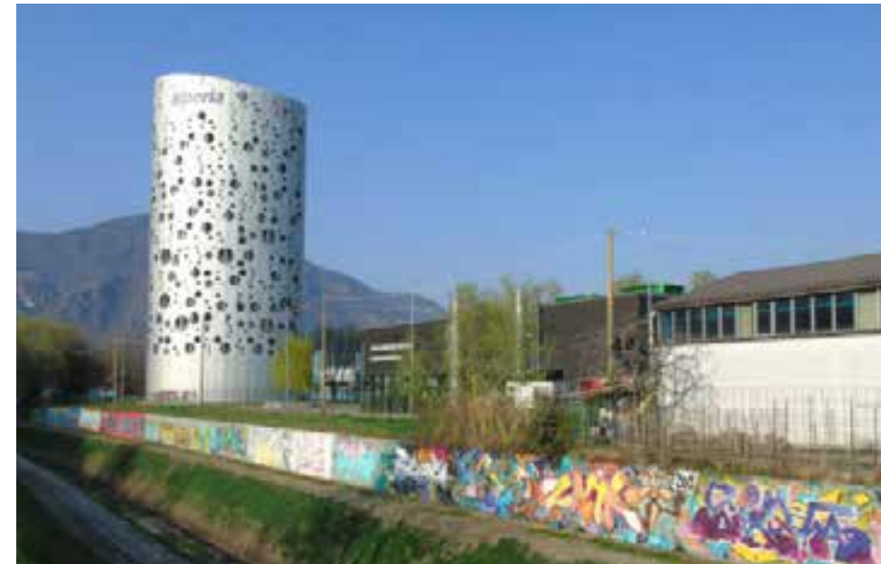
Das Fernheizkraftwerk Bozen versorgt tausende Wohnungen und verschiedene öffentliche Einrichtungen.
