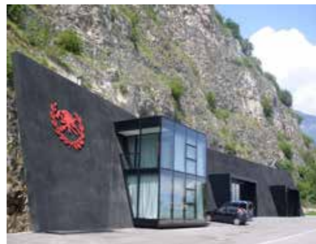
Stazione vigili del fuoco di Magrè. Anche i servizi antincendi (art. 4 StA) sono ancora formalmente di competenza regionale.
